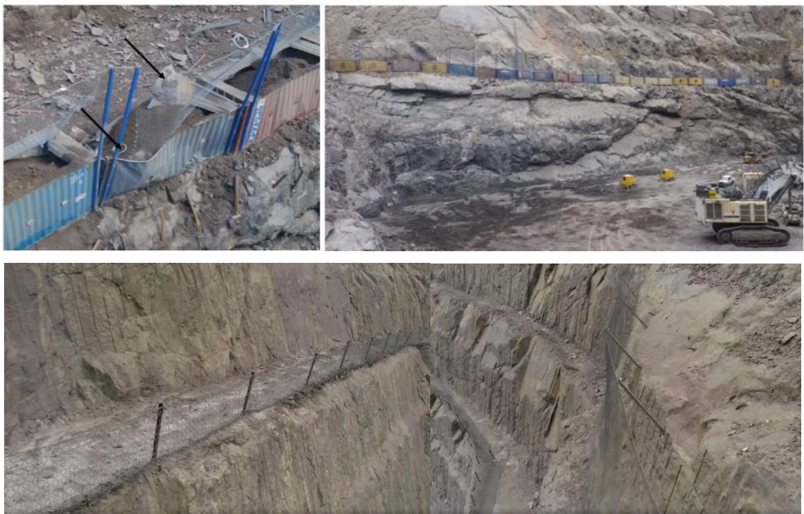
Рисунок 4.2 – Камнеулавливающие барьеры и сети
