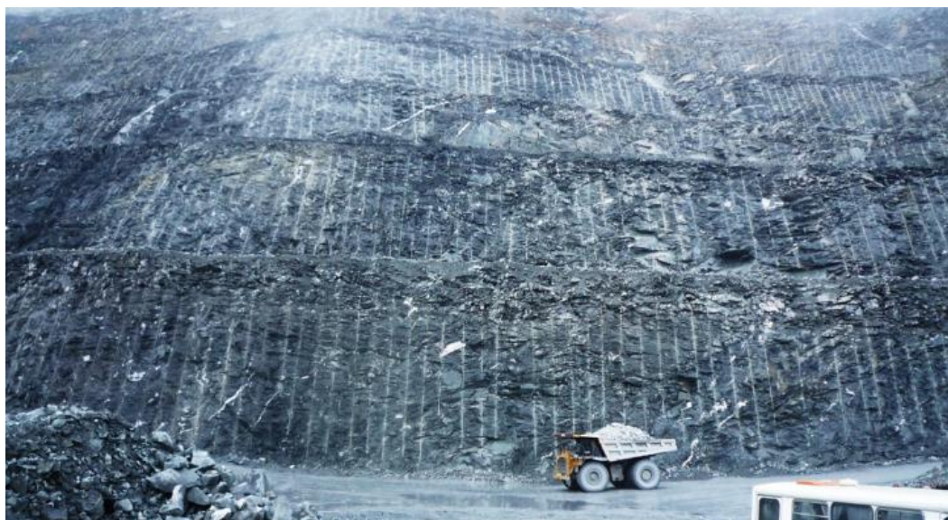
Рисунок 4.7 – Пример качественных результатов заоткосных работ
