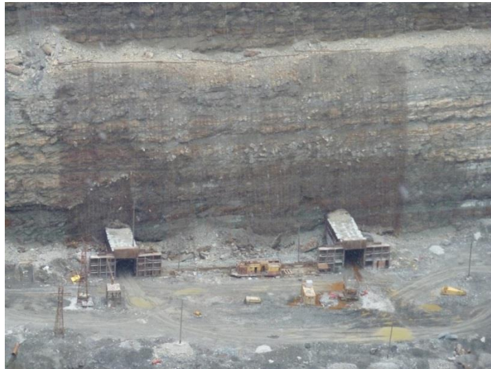
Рисунок 4.1 – Примеры защиты от камнепада металлическими сетками
